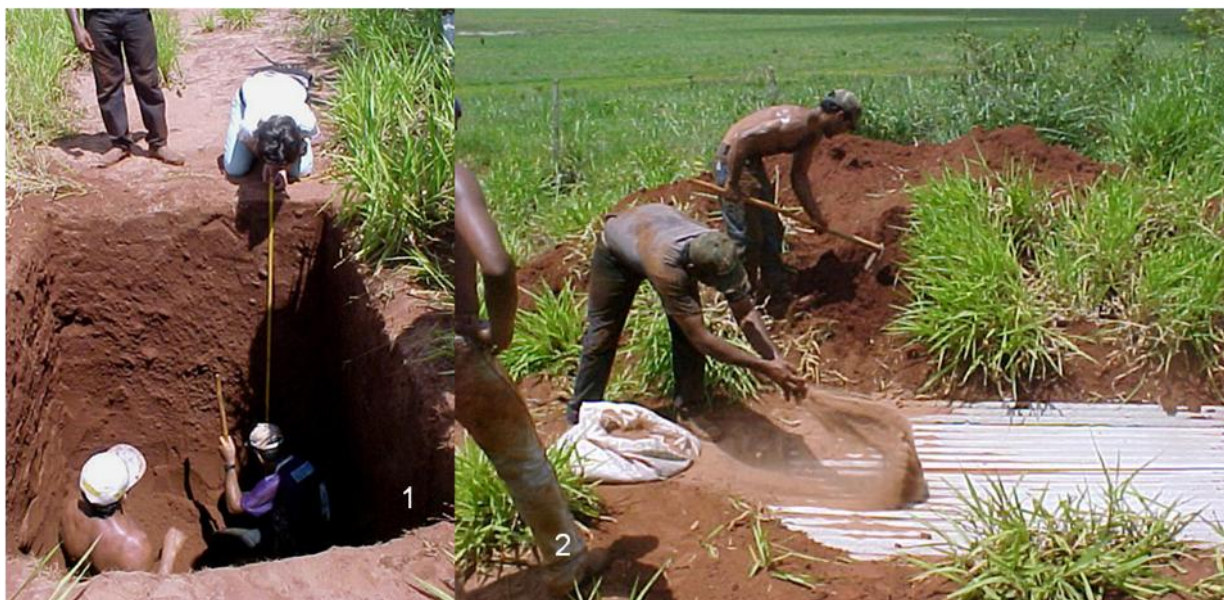
Figura 1 - Processo de construção de uma armadilha de trincheira
