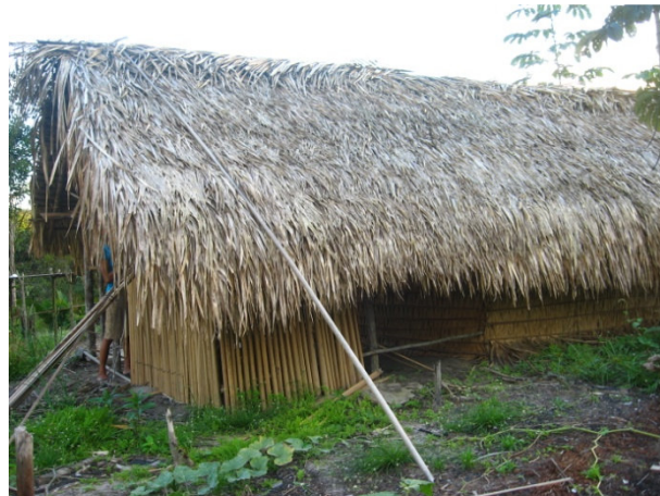
Figura 5. Casa construída com madeira e palha na aldeia Vila Nova II (rio Marau).
